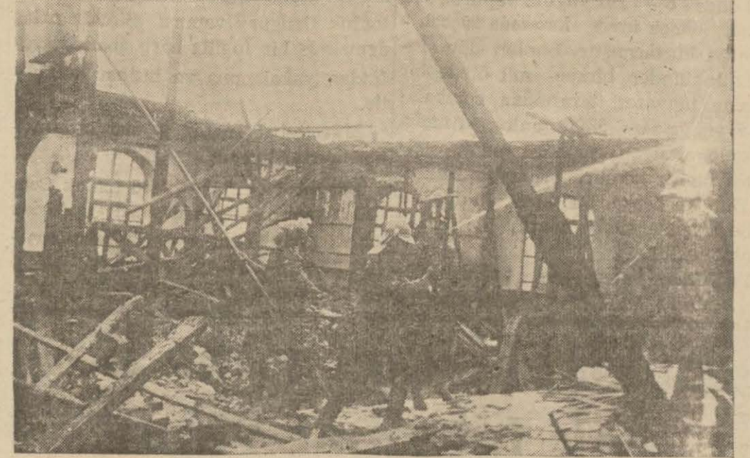
Yangın yerinden bir görünüş
